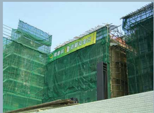
白加道之建築工程 Construction works at Barker Road
