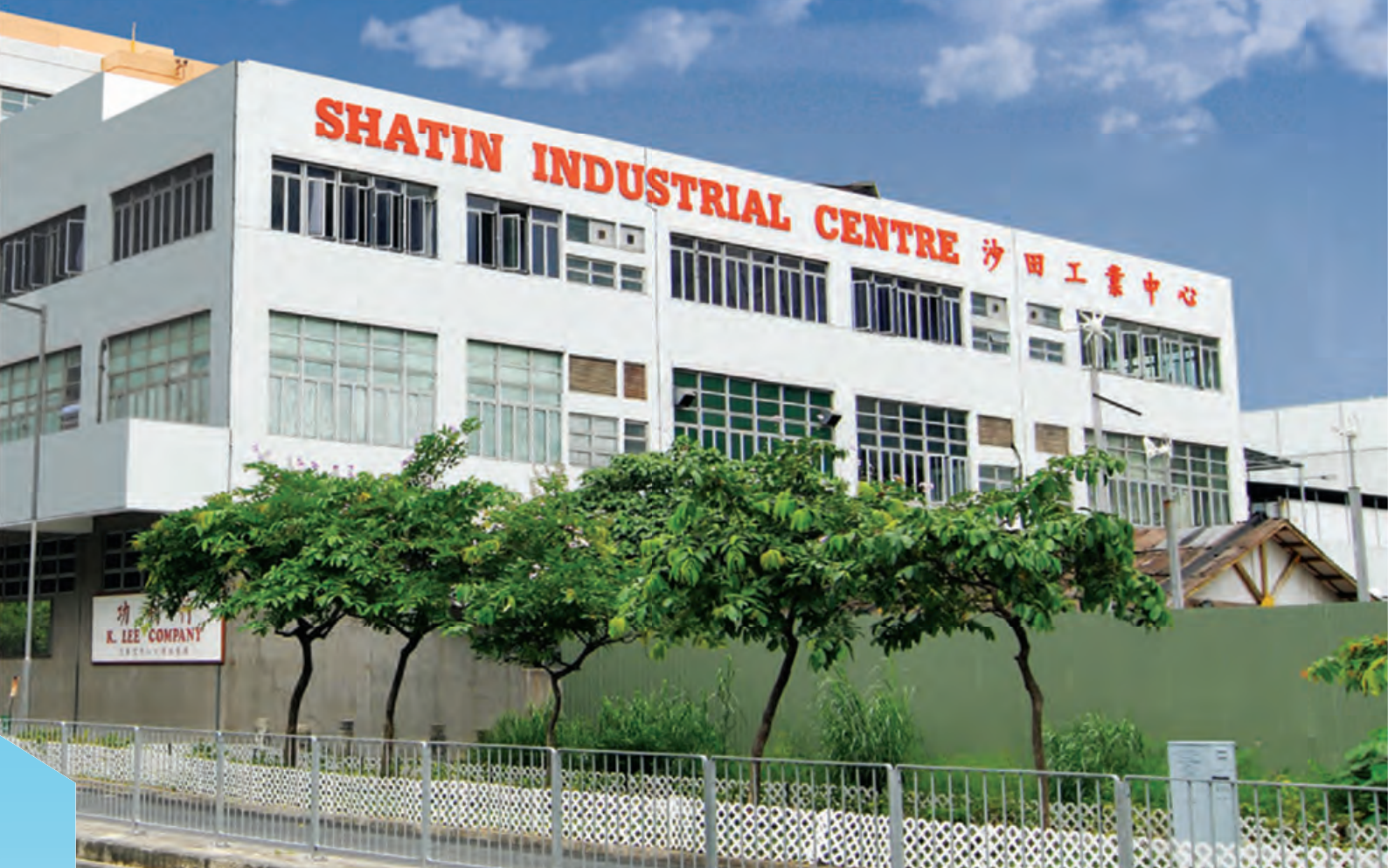
Shatin Industrial Centre 沙田工業中心
